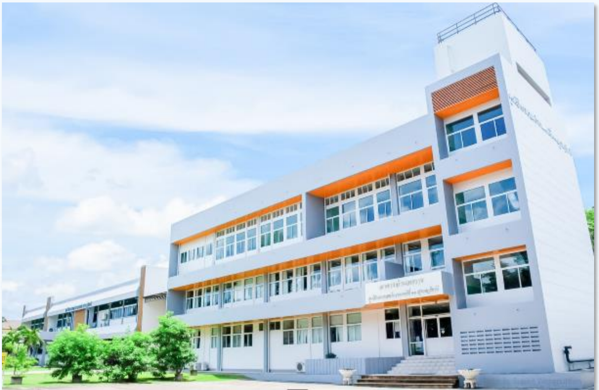
อาคารอำนวยการ
